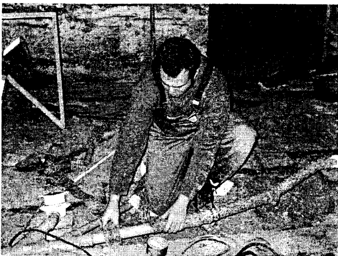
Abflussrohre für den Duschaum werden verlegt
