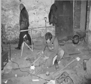
Der Wasch- und Duschraum entsteht ...
